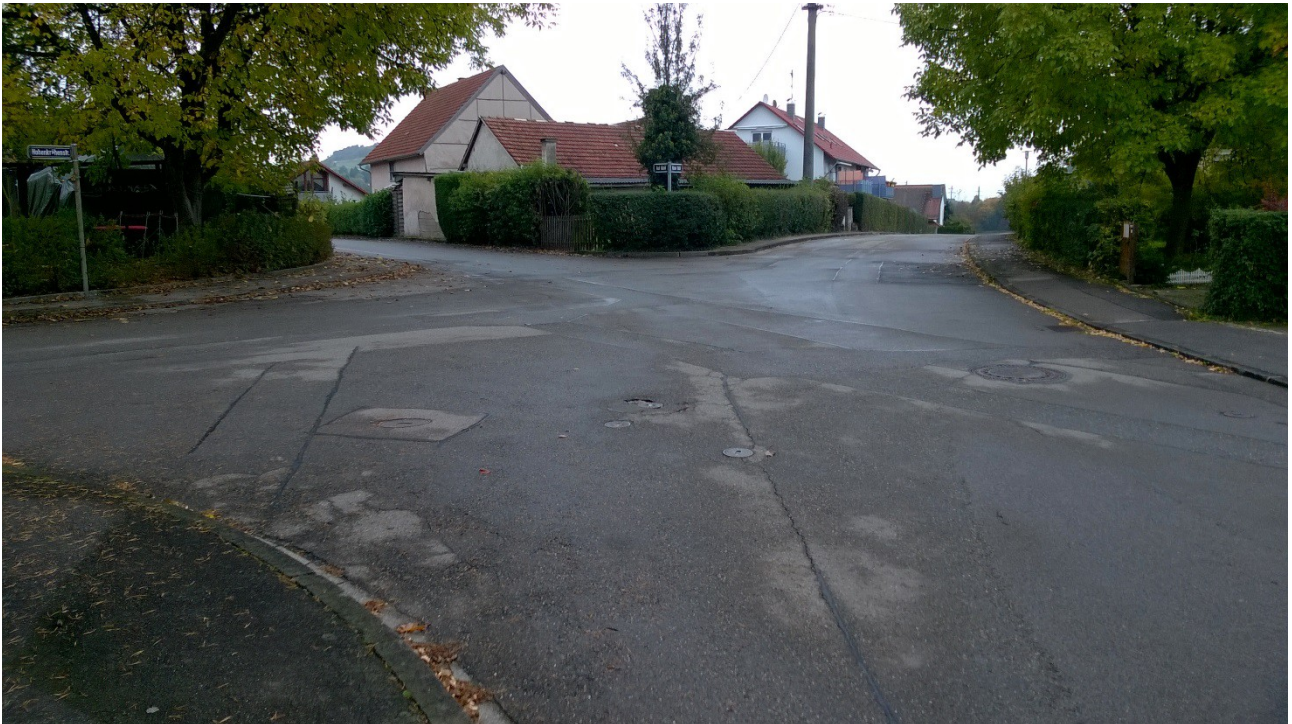
Beispiel für noch durchzuführende Absenkungen
